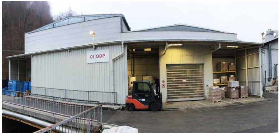
Slika 1: Zunanost odpremnega skladišča na Izlakah pred prenovo
