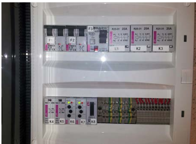
Zaščita in upravljanje električne polnilne postaje
